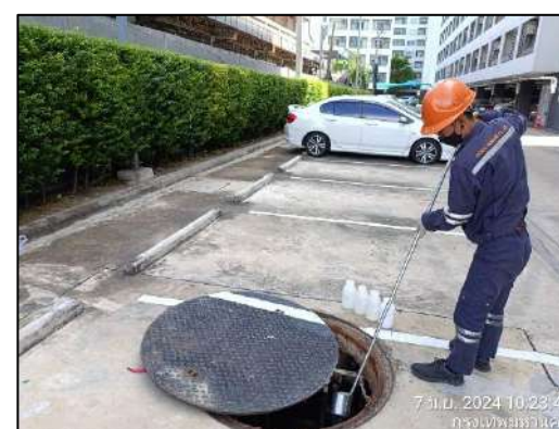
ภาพที่ 4.3 การตรวจวัดค่าน้ำบ่อบำบัดรายเดือน
