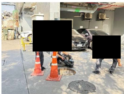
ช่างตัดกากไขมันระบบบำบัดน้ำเสีย
