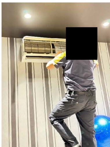
ช่างดำเนินการทำความสะอาดเครื่องปรับอากาศพื้นที่ส่วนกลาง
