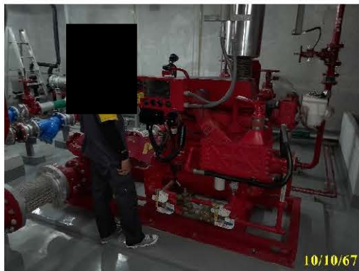
ช่างดำเนินการตรวจสอบเช็คระบบจ่ายน้ำดับเพลิง
