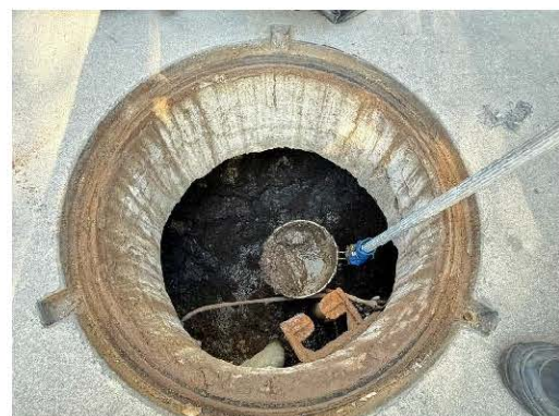
ช่างตัดกากไขมันระบบบำบัดน้ำเสีย
