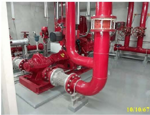
เครื่องสูบน้ำดับเพลิง (Pire Pump)
