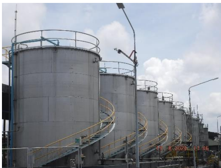
ภาพที่ 2.2-11 แท็งก์รองรับน้ำปนเปื้อนสำรอง
