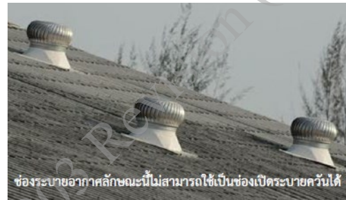
ช่องระบายแบบนี้ไม่ถือว่าเป็นช่องเปิดระบายควัน เนื่องจากไม่สามารถทำงานได้ภายใต้ฉุกเฉินสูง
