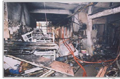
ภาพความเสียหายของการระเบิดของท่อ ออกซิเจนเนื่องจากไม่มีการติดตั้งอุปกรณ์ ป้องกันไฟย้อนกลับ
