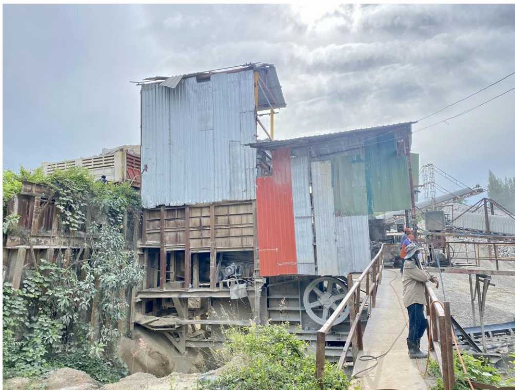
ภาพที่ 9.1 ติดตั้ง Metal sheet ปิดคลุมอาคารโรงโม่หินบริเวณปากใหญ่
