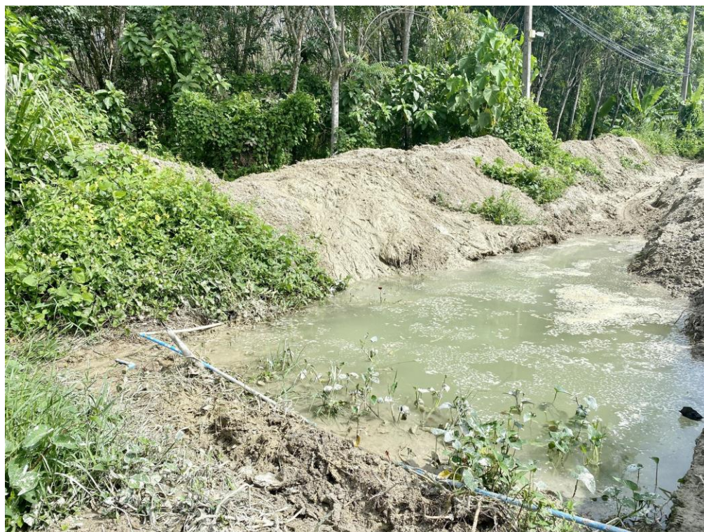
ภาพที่ 10 บ่อดักตะกอนดินเพื่อรองรับน้ำขุ่นจากบริเวณโรงไม้หิน
