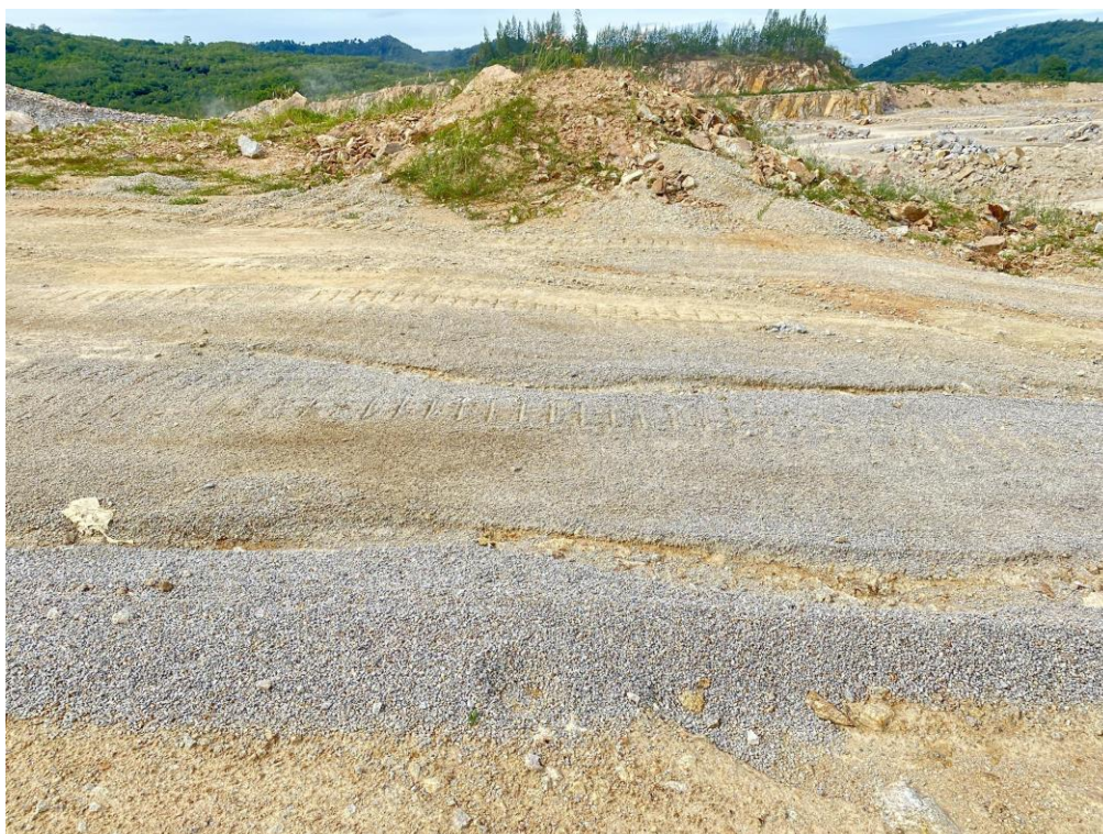
ภาพที่ 6 นำเปลือกดินดังกล่าวไปถมเพื่อทำการปรับพื้นที่และสร้างถนน
