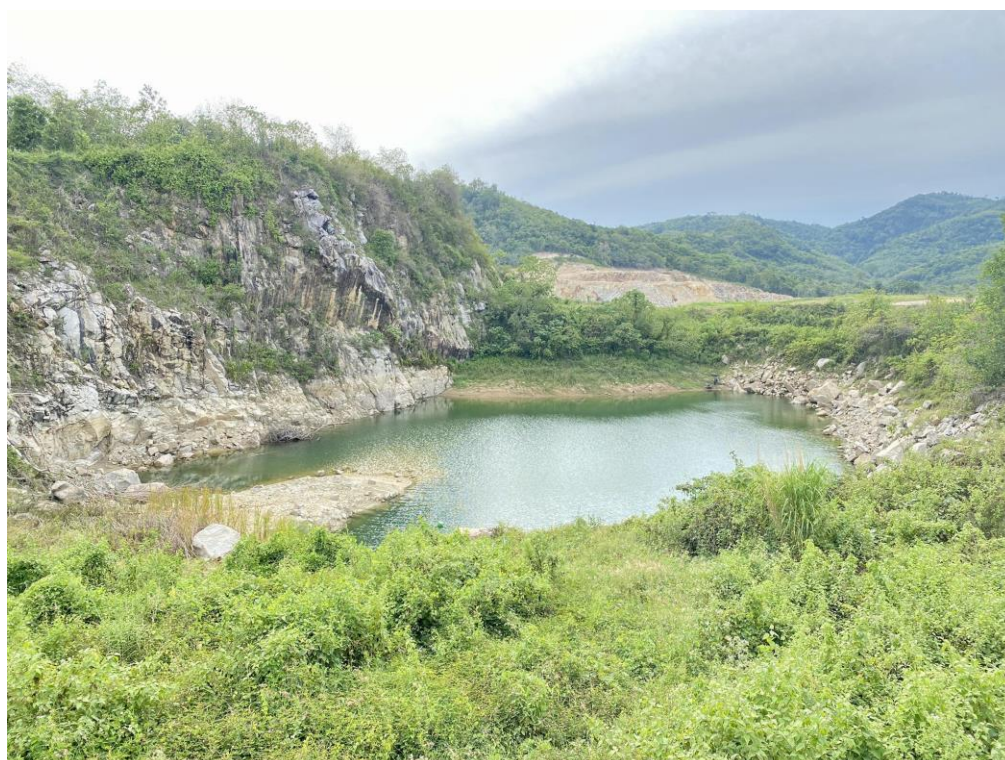
ภาพที่ 8 ชุมน้ำบนหน้าเหมืองเป็นบ่อดักตะกอนจากหน้าเหมือง
