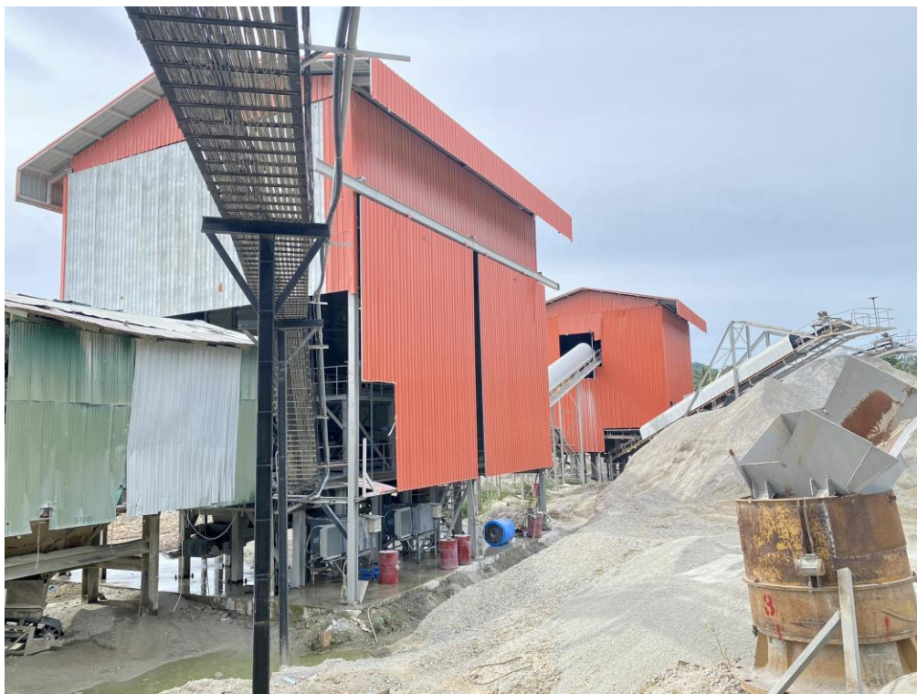
ภาพที่ 9.3 ติดตั้ง Metal sheet ปิดคลุมอาคารโรงไม้หินบริเวณบดย่อย
