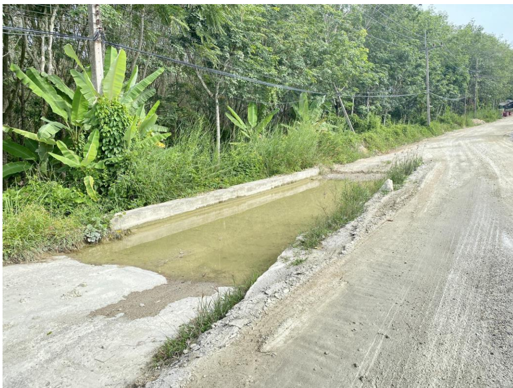
ภาพที่ 12 บ่อล้างล้อรถบรรทุกก่อนขึ้นตาชั่ง
