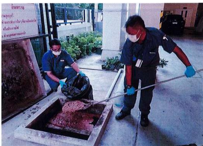
ภาพที่ 1-8 เจ้าหน้าที่ดักไขมัน และมิเตอร์ไฟฟ้าสำหรับระบบบำบัดน้ำเสีย
