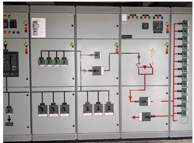
ภาพที่ 1-14 แผงจ่ายไฟฟ้าหลักของโครงการ
