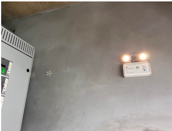
ภาพที่ 1-15 ไฟฉุกเฉินของโครงการ
