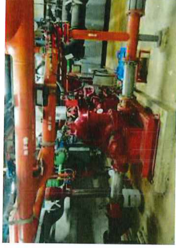
เครื่องสูบน้ำดับเพลิง
