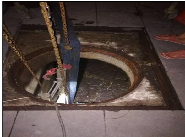
10.10 ตรวจสอบเส้นท่อประปาและการทำงานของเครื่องสูบน้ำและวาล์วต่างๆ เดือนละ 1 ครั้ง
