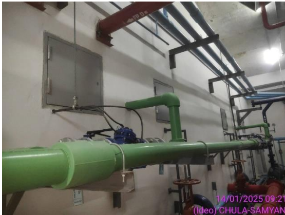
ระบบท่อน้ำปะปกก่อนเข้างัดเก็บน้ำ
