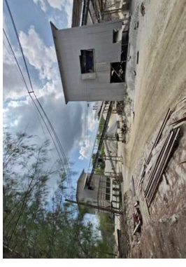
ภาพที่ 11.2 การใช้ Metal Sheet ปัดคลุม อาคารปากโม่ Jaw Crusher
