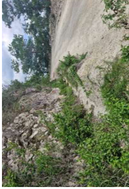
ภาพที่ 8 คุรระบายน้ำซึ่งขนานกับถนนชั้นยอดเขา ทำหน้าที่บังคับน้ำขุ่นจากหน้าเหมืองให้ไหล ลงสู่บ่อดักตะกอนดิน
