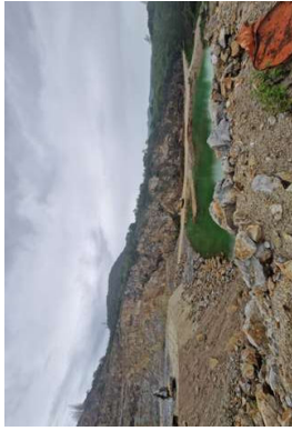
ภาพที่ 7 ขุมเหมืองด้านทิศตะวันตกเฉียงเหนือ เสมือนบ่อดักตะกอนดินจากหน้าเหมือง
