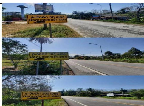
รูป U จัดทำป้ายสัญญาณเตือนระยะ 50, 100 และ 200 เมตร ช่วงก่อนเลี้ยวเข้า-ออก โครงการ
