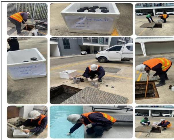
ภาคผนวกที่ 3.25 การจัดเก็บตัวอย่างน้ำเสียในระบบ
