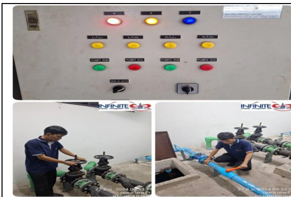
ภาคผนวกที่ 3.21 ตรวจสอบวาล์วเปิด-ปิด ถังเก็บน้ำ
