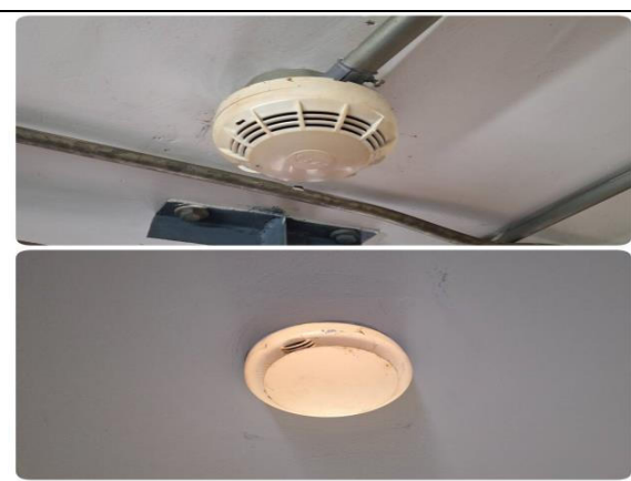
ภาคผนวกที่ 3.30 Smoke&Heat detector
