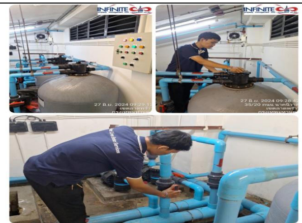
ภาคผนวกที่ 3.24 การทำความสะอาดระบบกรองสระน้ำ
