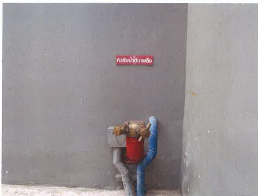
หัวรับน้ำดับเพลิงด้านหลังอาคาร
