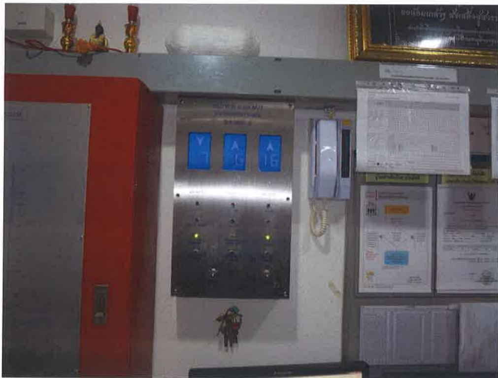
ภาพระบบแจ้งสถานะลิฟต์และอุปกรณ์รับแจ้งเหตุฉุกเฉินของระบบลิฟต์
