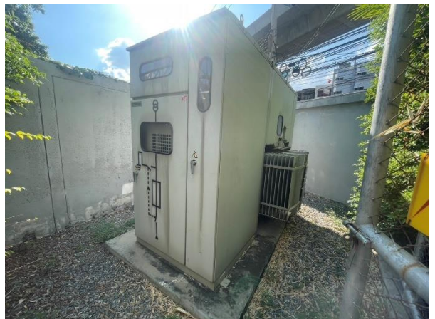
รูปที่ 34 หม้อแปลงไฟฟ้า
