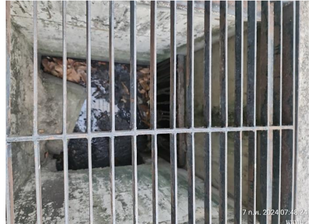
รูปที่ 26 ตะแกรงคัดขยะที่ Man Hole
