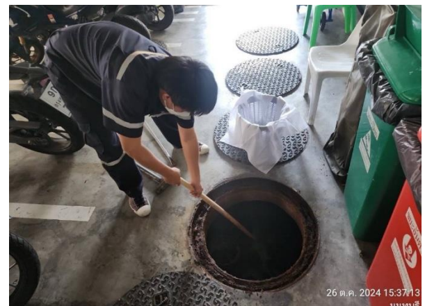
รูปที่ 18 เจ้าหน้าที่ตรวจเช็คบ่อดักไขมันและดักไขมัน
