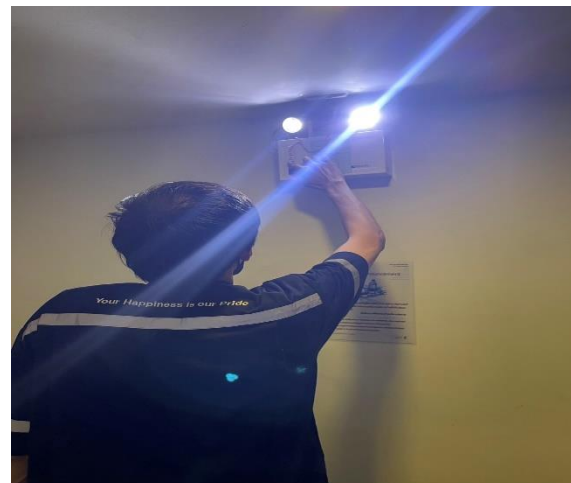
รูปที่ 58 ตรวจสอบเช็คไฟฉุกเฉินประจำเดือน
