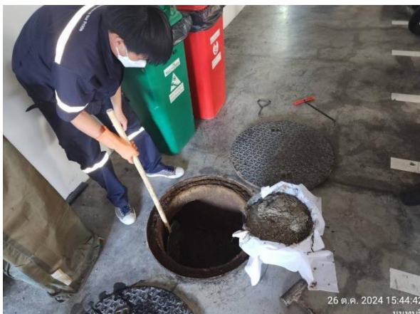
รูปที่ 17 เจ้าหน้าที่ตรวจเช็คบ่อดักไขมันและดักไขมัน
