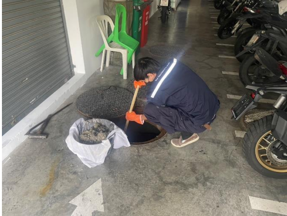
รูปที่ 19 เจ้าหน้าที่ตรวจเช็คบ่อดักไขมันและดักไขมัน
