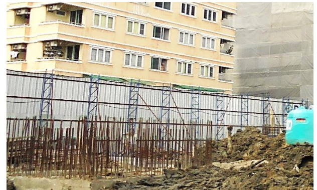
รูปที่ ก-2 รั้ว Metal Sheet สูง 6 เมตร โดยรอบบริเวณพื้นที่ก่อสร้าง
