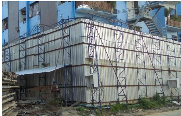
รูปที่ ก-2 รั้ว Metal Sheet สูง 6 เมตร โดยรอบบริเวณพื้นที่ก่อสร้าง
