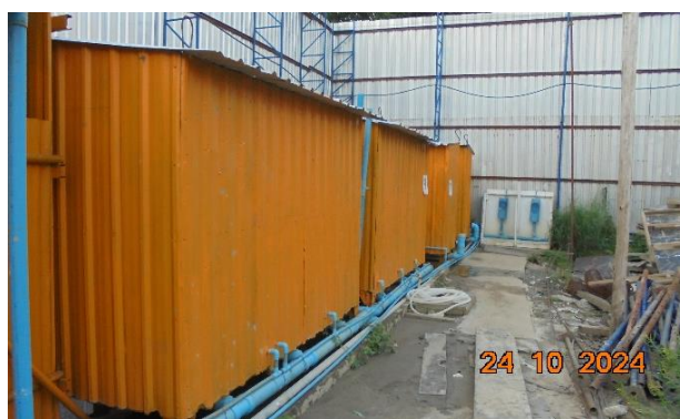
รูปที่ ก-30 ห้องน้ำ และระบบบำบัดสำเร็จรูป บริเวณพื้นที่ก่อสร้าง
