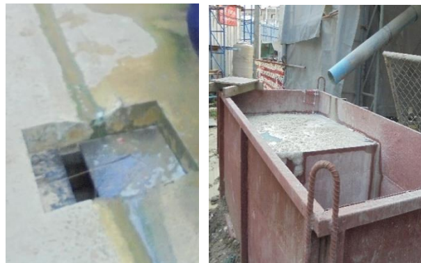
รูปที่ ก-29 ท่อระบายน้ำ และบ่อดักตะกอนดิน
