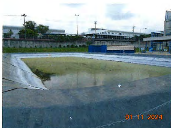
ภาพที่ 2.2-8 บ่อพักน้ำหล่อเย็น
