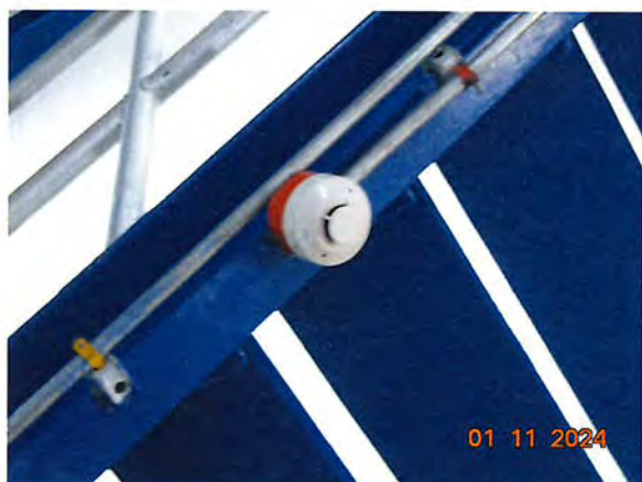
ภาพที่ 2.2-33 อุปกรณ์ตรวจจับควัน (Smoke Detector)
