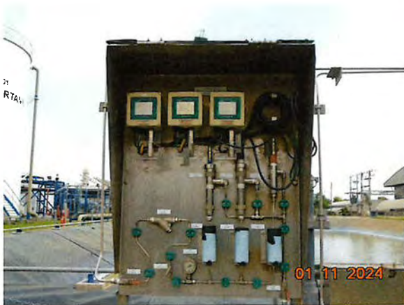
ภาพที่ 2.2-9 ระบบตรวจสอบคุณภาพน้ำแบบต่อเนื่อง Online Monitoring บริเวณบ่อกักน้ำหล่อเย็น
