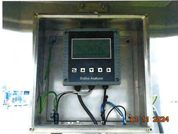
ภาพที่ 2.2-9 ระบบตรวจสอบคุณภาพน้ำแบบต่อเนื่อง Online Monitoring บริเวณบ่อกักน้ำหล่อเย็น
