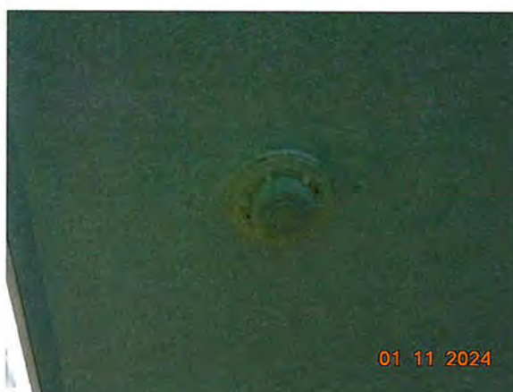
ภาพที่ 2.2-34 อุปกรณ์ตรวจจับความร้อน (Heat Detector)
