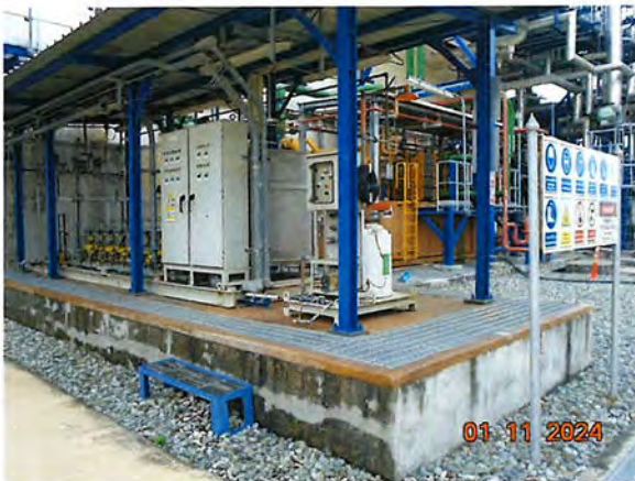
ภาพที่ 2.2-51 คันกัน (Dike) กักเก็บสารเคมี
