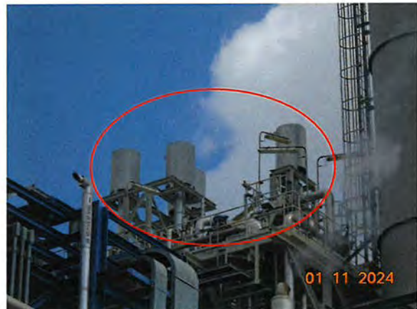
ภาพที่ 2.2-4 อุปกรณ์ช่วยในการลดเสียง (Silencer)
