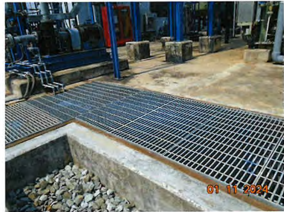
ภาพที่ 2.2-52 รางระบายบริเวณสถานที่เก็บสารเคมี
