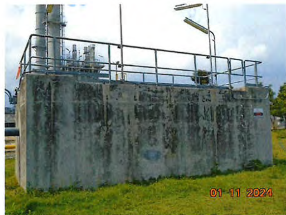
ภาพที่ 2.2-13 บ่อแยกน้ำ/น้ำมัน (Oil Separator)
