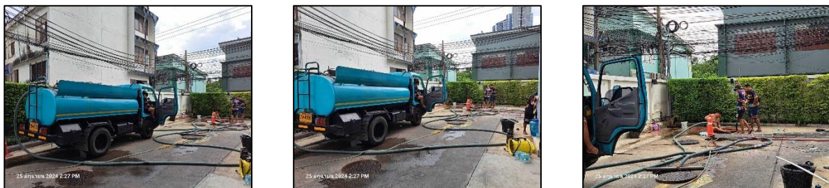
ภาพที่ 2.2-12 เจ้าหน้าที่ทำการสูบตะกอนของระบบบำบัดน้ำเสีย
