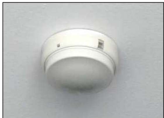
ภาพที่ 1-14 เครื่องตรวจจับความร้อน
