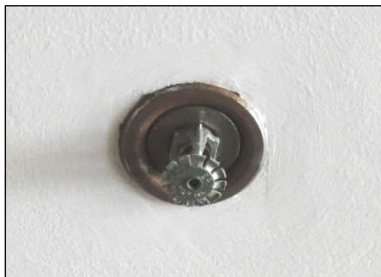
ภาพที่ 1-17 ระบบโปรยน้ำดับเพลิงอัตโนมัติ
