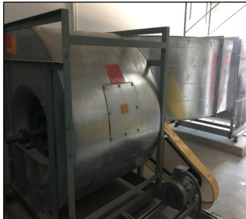
ภาพที่ 1-18 บันไดหนีไฟและพัดลมอัดอากาศ
