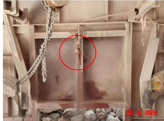
ระบบเตรียมน้ำบริเวณจุดกำเนิดฝุ่นละออง
