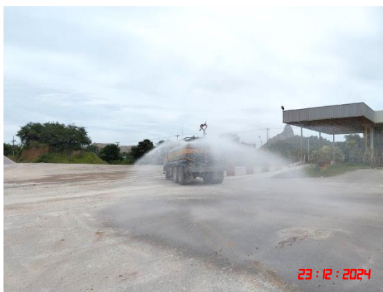
รูปที่ 10 การฉีดพรมน้ำเพื่อลดการฟุ้งกระจายของฝุ่นละออง
