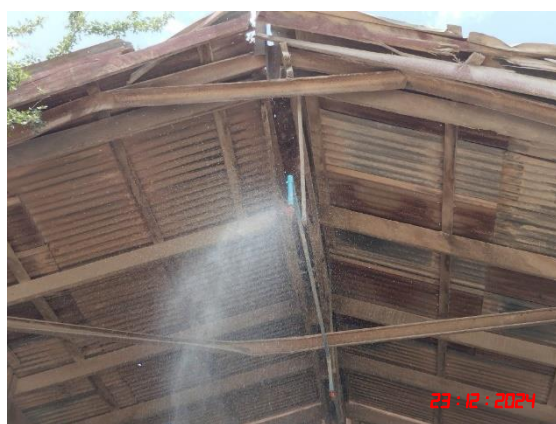
ระบบสเปรย์น้ำภายในอาคาร
