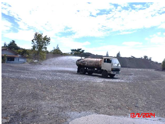
รูปที่ 10 การฉีดพรมน้ำเพื่อป้องกันและลดผลกระทบด้านฝุ่นละออง
