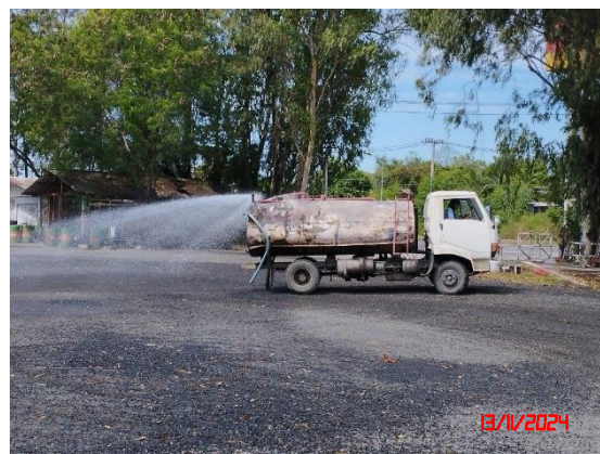
รูปที่ 10 การฉีดพรมน้ำเพื่อป้องกันและลดผลกระทบด้านฝุ่นละออง
