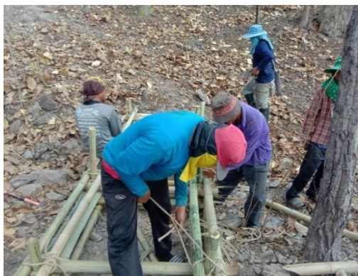
รูปที่ 5.1.2-4 การก่อสร้างฝายต้นน้ำแบบคอกหมู ขนาด 3 เมตร จำนวน 20 แห่ง
