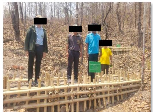
รูปที่ 5.1.2-6 การก่อสร้างฝายต้นน้ำแบบคอกหมู ขนาด 4 เมตร จำนวน 21 แห่ง
