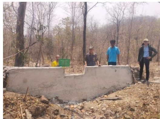
รูปที่ 5.1.2-8 การก่อสร้างฝายต้นน้ำแบบกึ่งถาวร ขนาด 4 เมตร จำนวน 10 แห่ง
