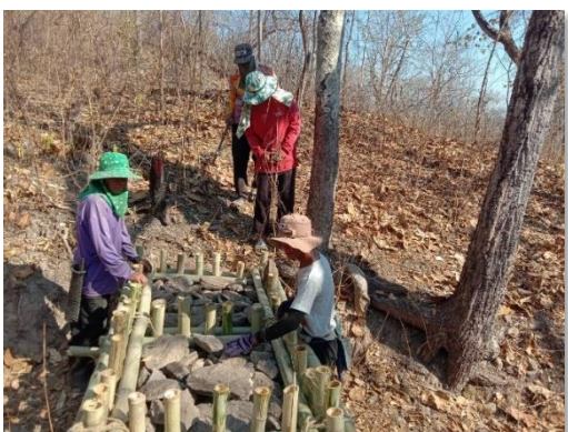
รูปที่ 5.1.2-6 การก่อสร้างฝายต้นน้ำแบบคอกหมู ขนาด 4 เมตร จำนวน 21 แห่ง
