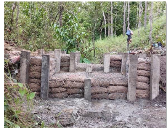
รูปที่ 5.1.2-3 ผลการดำเนินการก่อสร้างฝายต้นน้ำแบบกล่องเกเบี้ยนชนิดกระสอบดินทรายผสมซีเมนต์
