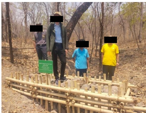
รูปที่ 5.1.2-4 การก่อสร้างฝายต้นน้ำแบบคอกหมู ขนาด 3 เมตร จำนวน 20 แห่ง
