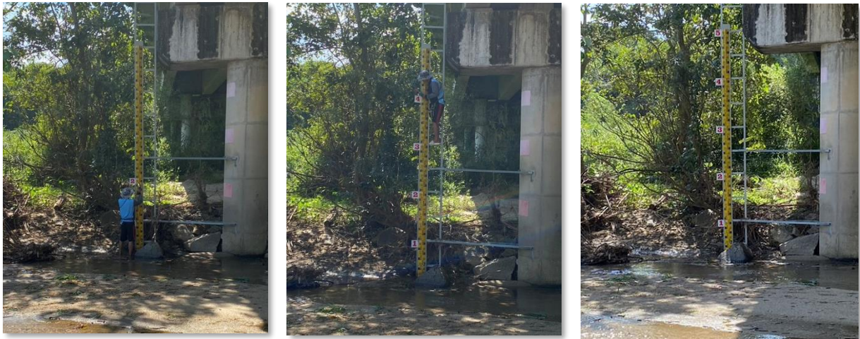
รูปที่ 5.2.1-4 การตั้งเลขบอกระดับหัวแผ่นวัดระดับน้ำ (Staff Guage)
