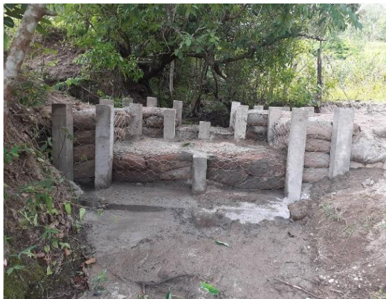
รูปที่ 5.1.2-3 ผลการดำเนินการก่อสร้างฝายต้นน้ำแบบกล่องเกเบี้ยนชนิดกระสอบดินทรายผสมซีเมนต์
