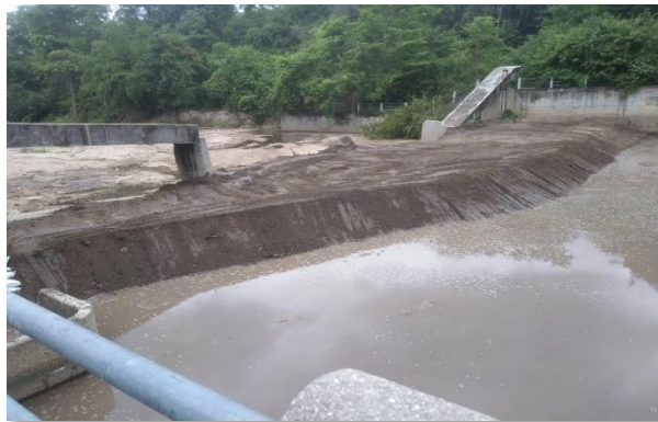
รูปที่ 5.1.8-2 ผลการดำเนินงานขุดลอกตะกอน และกิจกรรมทำนบฝายชั่วคราว
