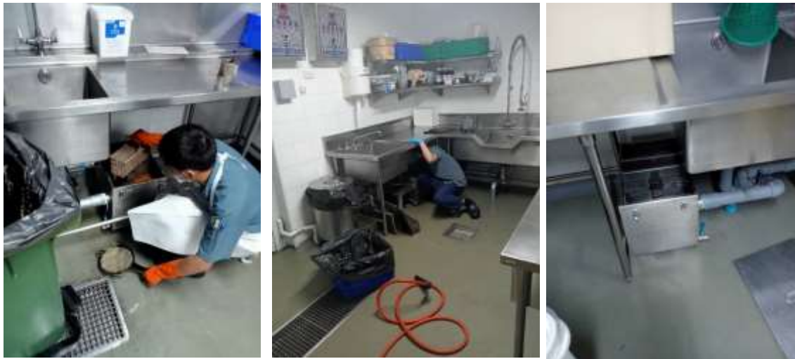
ภาพที่ ๕ - ๙ ถึงตัดไขมนในห้องครัว ตัดไขมนทุกสัปดาห์
