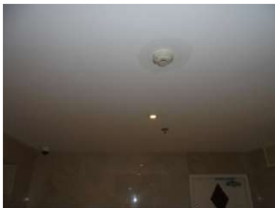
ภาพที่ 5-22 Smoke Detector และ Sprinkler
