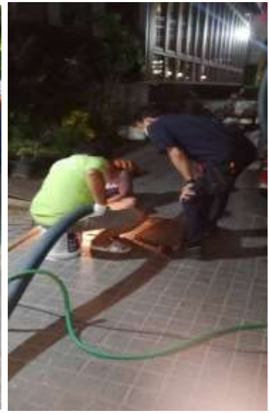
ภาพที่ 5- 8 ระบบบำบัดน้ำเสียและการสูบน้ำออกจากบ่อพักตะกอน
