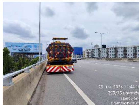
รูปที่ 2-6 การทำความสะอาดพื้นผิวจราจรด้วยรถดูดกวาด
