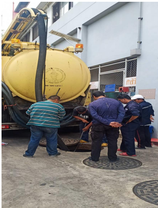
ภาพที่ 16 การกำจัดไขมันในระบบบำบัดน้ำเสีย
