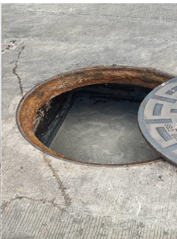
ภาพที่ 16 การกำจัดไขมันในระบบบำบัดน้ำเสีย
