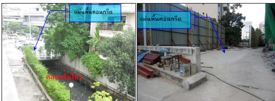
ภาพที่ 2.1-1 สภาพแผ่นพื้นคอนกรีตพาดเรียงอยู่บนคลองตันไทร
