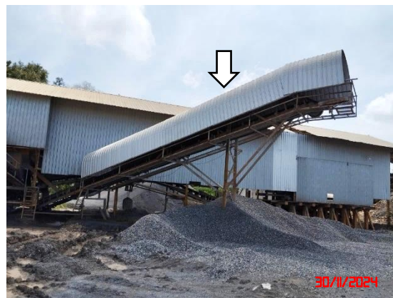
หลังคาปิดคลุมระบบสายพานลำเลียง
