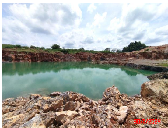
รูปที่ 23 บ่อรองรับน้ำ (Sump) ในขุมเหมือง
