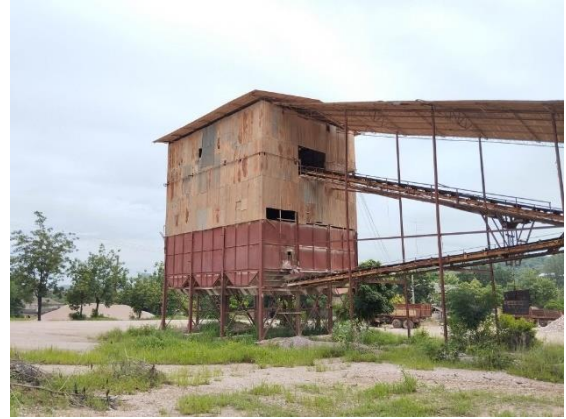
รูปที่ 8 อาคารปิดคลุมโรงโม่หินทั้ง 3 ด้าน
