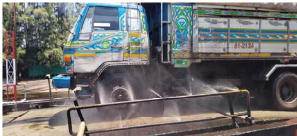
รูปที่ 2-5 การล้างล้อรถบรรทุก
