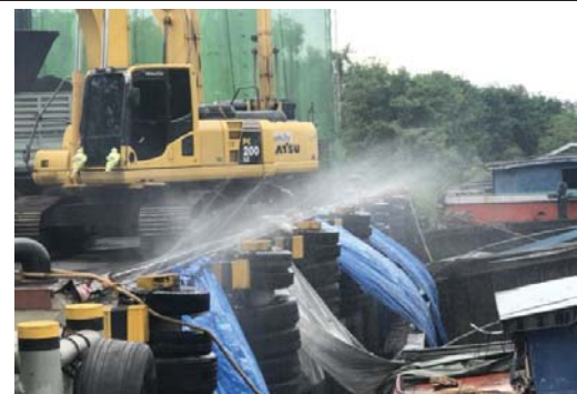
รูปที่ 2-15 ภาพการฉีดน้ำขณะขนถ่ายสินค้า
