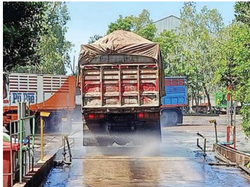
รูปที่ 2-12 การล้างล้อรถบรรทุก
