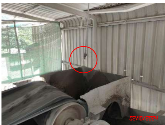
ระบบสเปรย์น้ำบริเวณที่ก่อให้เกิดฝุ่นละออง
