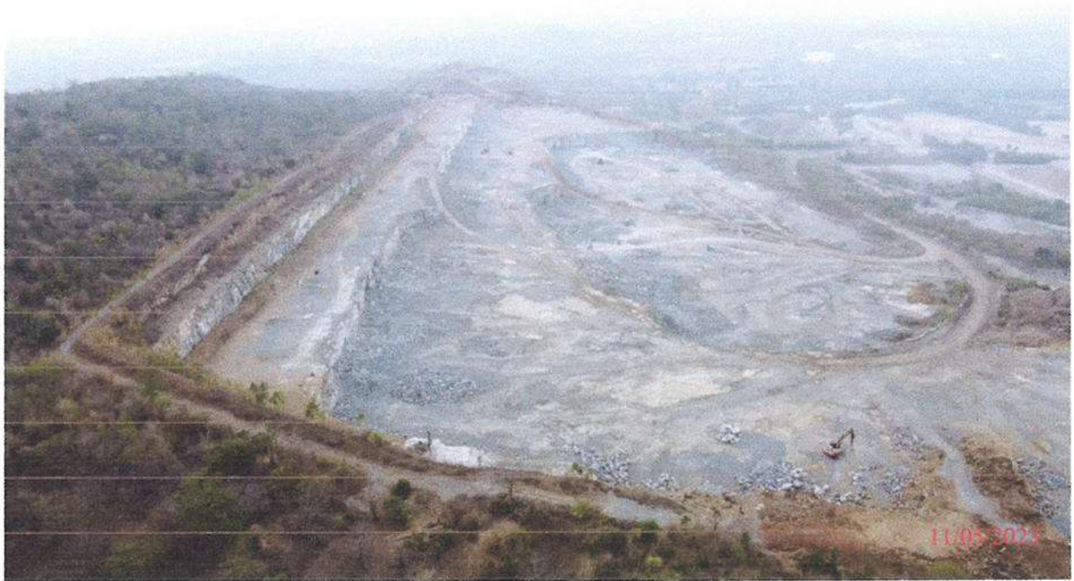
ภาพที่ ๒ : การปรับสภาพและฟื้นฟูพื้นที่บริเวณหน้าเหมือง ให้มีลักษณะเป็นขั้นบันไดเพื่อความปลอดภัย
