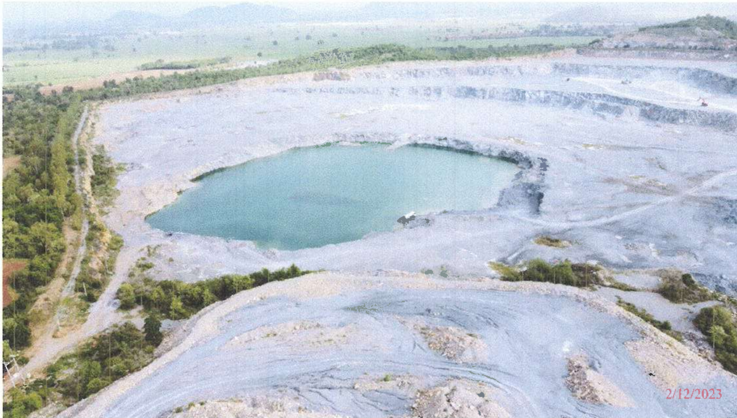
ภาพที่ 8 : บ่อพักน้ำดักตะกอนบริเวณที่พื้นที่ต่ำสุดของหน้าเหมืองภายในพื้นที่โครงการ
