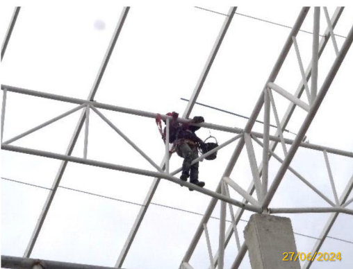
ภาพที่ 21 คนงานที่ทำงานบนที่สูงสวมใส่อุปกรณ์ป้องกันอันตรายส่วนบุคคล (PPE)
