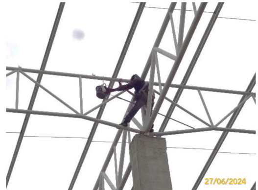
ภาพที่ 21 คนงานที่ทำงานบนที่สูงสวมใส่อุปกรณ์ป้องกันอันตรายส่วนบุคคล (PPE)
