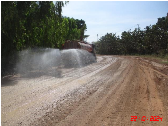
รูปที่ 10 การเก็บกวาดฝุ่นละอองที่ตกค้างสะสมบริเวณพื้นที่โรงโม่หินและเส้นทางลำเลียงแร่
