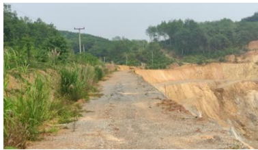
รูปที่ 2-25 คันทำนบดินและคุระบายน้ำตามแนวเส้นทางทำเหมืองในระยะ 10 ม. รอบพื้นที่โครงการ
