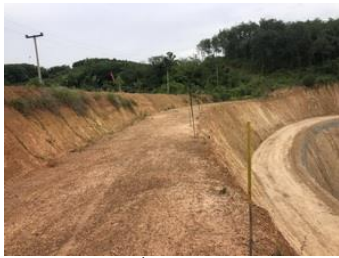
รูปที่ 2-6 คันทำนบดิน ถนน คุระบายน้ำ และบ่อดักตะกอน ที่ใช้เปลือกดินส่วนใหญ่ในการปรับแต่ง
