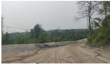
รูปที่ 2-6 คันทำนบดิน ถนน คุระบายน้ำ และบ่อดักตะกอน ที่ใช้เปลือกดินส่วนใหญ่ในการปรับแต่ง
