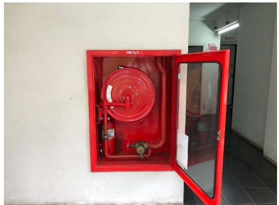
รูปที่ 18 สายฉีดน้ำดับเพลิงในตัวอาคาร
