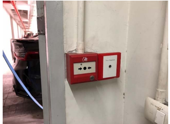
รูปที่ 16 อุปกรณ์แจ้งเตือนเพลิงด้วยมือถือ
