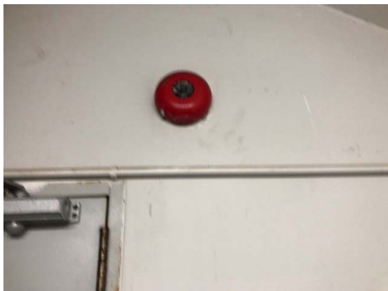
รูปที่ 19 ระบบเตือนดับเพลิงด้วยเสียง
