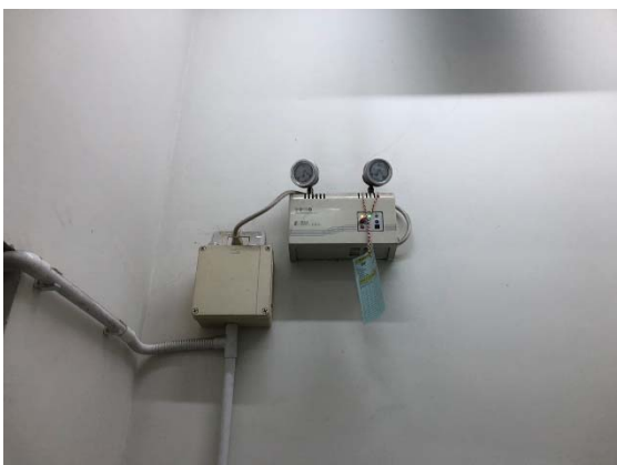
รูปที่ 35 ไฟสำรองกรณีเกิดเหตุไฟไหม้
