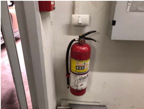
รูปที่ 15 ถังดับเพลิงแบบมือถือ
