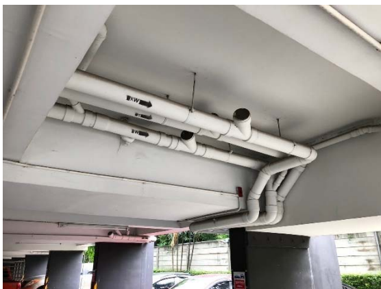
รูปที่ 11 ท่อส่งน้ำประปาภายในโครงการ
