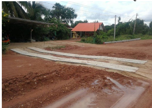
ข) การวางพื้นคอนกรีตและการถมดินชั่วคราว บริเวณทางเข้า-ออกที่อยู่อาศัย
