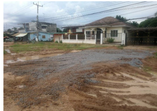
ข) การวางพื้นคอนกรีตและการถมดินชั่วคราว บริเวณทางเข้า-ออกที่อยู่อาศัย
