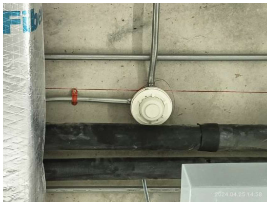
รูปที่ 3-55 เครื่องตรวจจับความร้อน (Heat Detector)
