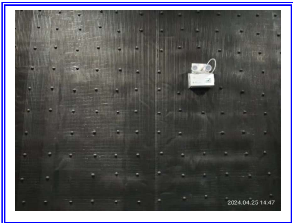
รูปที่ 3-38 ติดตั้งวัสดุกันเสียงภายในห้องเครื่องกำเนิดไฟฟ้า
