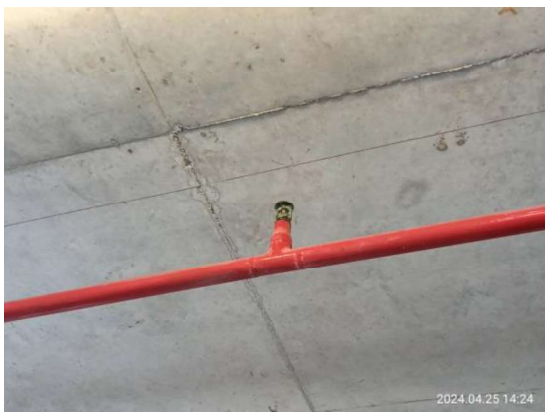
รูปที่ 3-51 ระบบหัวกระจายน้ำดับเพลิง
