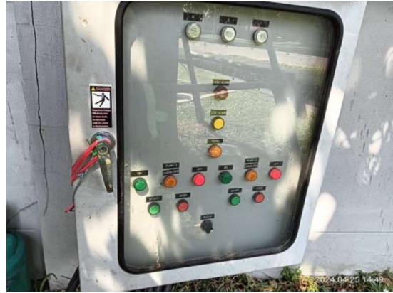
รูปที่ 3-28 ตู้ควบคุมเครื่องสูบน้ำ
