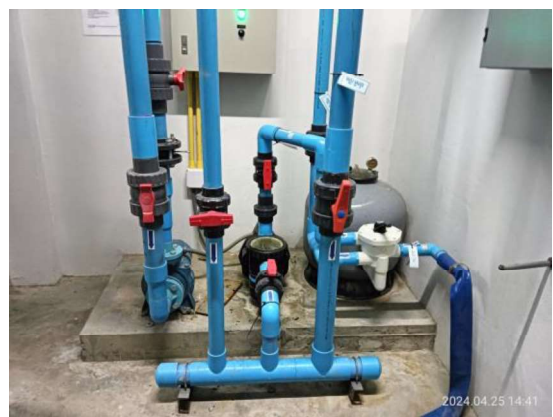
รูปที่ 3-19 ระบบสูบน้ำภายในห้องระบบบำบัดน้ำเสีย
