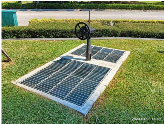
รูปที่ 3-27 ระบบพองน้ำภายในโครงการและบริเวณ บ่อตกขยะและบ่อตรวจคุณภาพน้ำ
