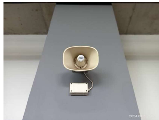
รูปที่ 3-57 ลำโพงแจ้งสัญญาณเตือนอัคคีภัย (Alarm Horn With Strobe Light)
