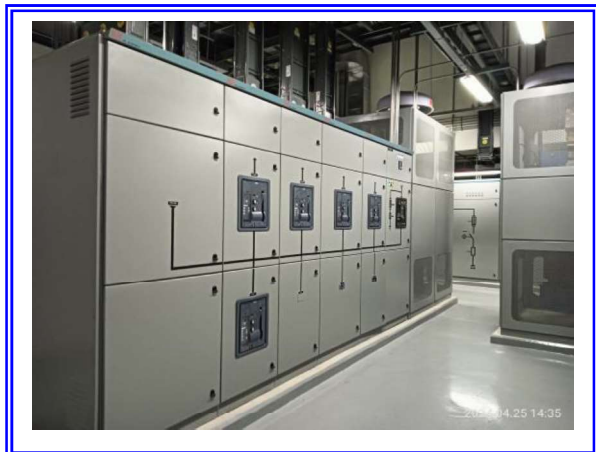
รูปที่ 3-36 ระบบมิเตอร์ไฟฟ้าส่วนกลาง
