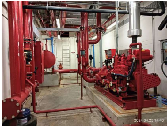
รูปที่ 3-45 เครื่องสูบน้ำดับเพลิง
