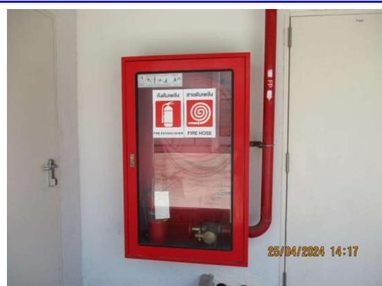
รูปที่ 3-48 ตู้เก็บสายฉีดน้ำดับเพลิงพร้อมอุปกรณ์
