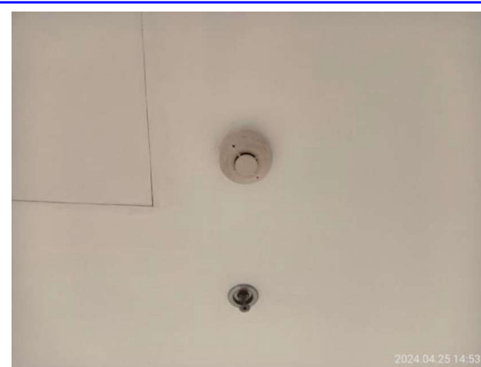
รูปที่ 3-54 เครื่องตรวจจับควัน (Smoke Detector)
