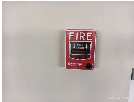
รูปที่ 3-56 เครื่องแจ้งเหตุโดยใช้มือดึง (Manual Station)
