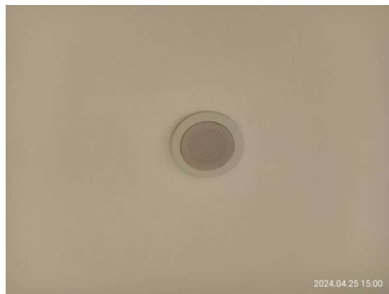
รูปที่ 3-57 ลำโพงแจ้งสัญญาณเตือนอัคคีภัย (Alarm Horn With Strobe Light)
