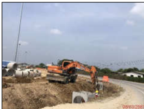
การก่อสร้างระบบระบายน้ำ (ด้านเก็บค่าผ่านทางนครปฐมฝั่งตะวันตก)
