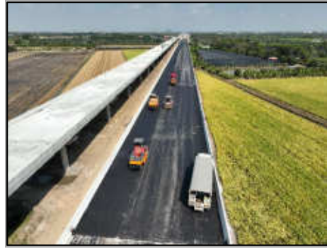
การปูผิวแอสฟัลต์บนโครงสร้างสะพานยกระดับ (โครงการฯ ตอน 4)
