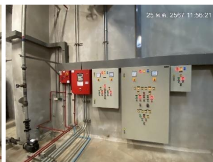
ระบบสูบน้ำสำรองดับเพลิง
