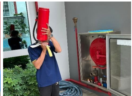
เจ้าหน้าที่ตรวจเช็คตู้เก็บสายฉีดน้ำดับเพลิงและถังเคมีดับเพลิง
