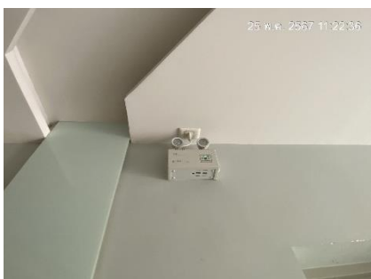
ไฟส่องสว่างฉุกเฉิน รูปที่ 2.1-14 ระบบป้องกันอัคคีภัย
