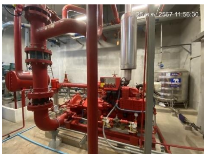
ระบบสูบน้ำสำรองดับเพลิง
