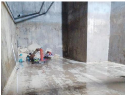
เจ้าหน้าที่ตรวจล้างถังเก็บน้ำสำรองและเช็คสภาพถังเก็บน้ำสำรอง
