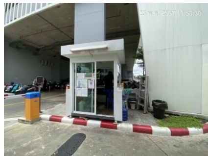
ไม้กั้นรถบริเวณทางเข้า-ออกโครงการ/ระบบบัตรอิเล็กทรอนิกส์ (Key Card)
