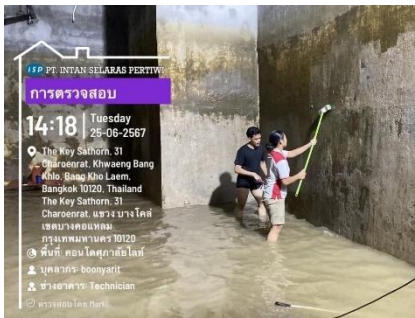
เจ้าหน้าที่ตรวจล้างถังเก็บน้ำสำรองและเช็คสภาพถังเก็บน้ำสำรอง
