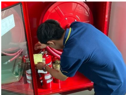
เจ้าหน้าที่ตรวจเช็คตู้เก็บสายฉีดน้ำดับเพลิงและถังเคมีดับเพลิง
