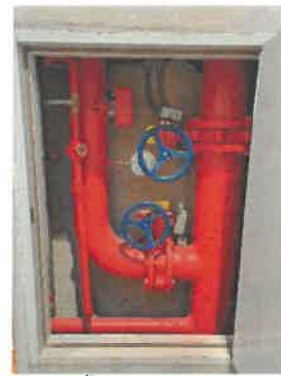
ระบบท่ออื่นเพื่อรับน้ำดับเพลิงจากถังเก็บน้ำชั้นใต้ดิน B2
