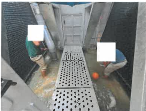
รูปที่ 35 การทำความสะอาด Cooling Tower
