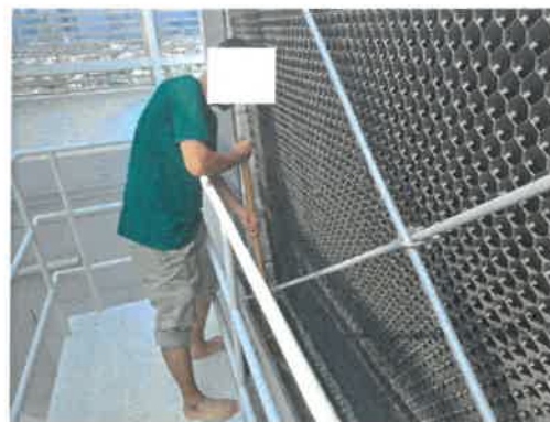
รูปที่ 35 การทำความสะอาด Cooling Tower
