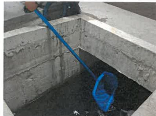
รูปที่ 3-5 การทำความสะอาดถึงเก็บน้ำ
