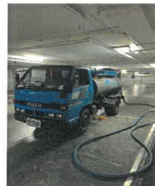
รูปที่ 11 การสูบลากตะกอนของระบบบำบัดน้ำเสีย
