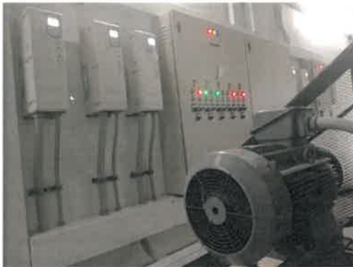
รูปที่ 26 อุปกรณ์ปรับความเร็วรอบมอเตอร์ (VSD)
