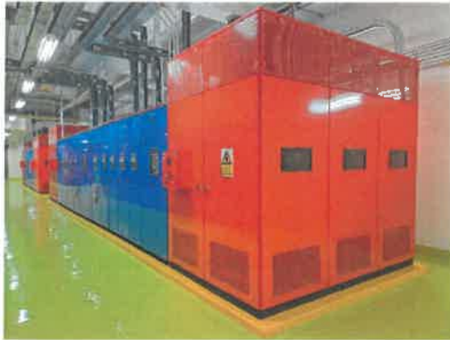
หม้อแปลงไฟฟ้า ชนิด Dry Type Case Resin
