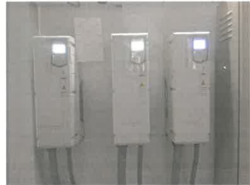
รูปที่ 26 อุปกรณ์ปรับความเร็วรอบมอเตอร์ (VSD)
