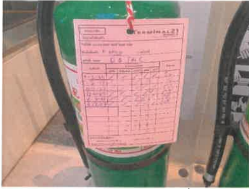
รูปที่ 3-14 การตรวจสอบอุปกรณ์ดับเพลิง
