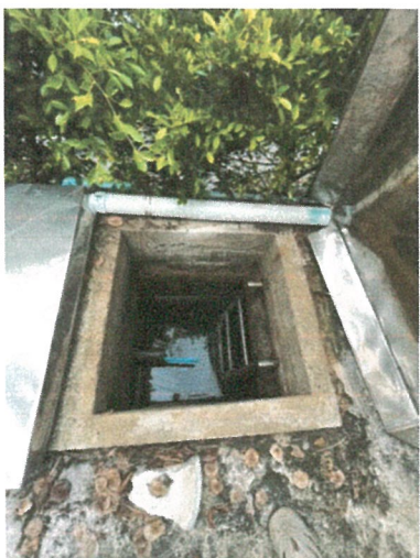
รูปภาพที่ 2.7 ถังเก็บน้ำใต้ดิน
