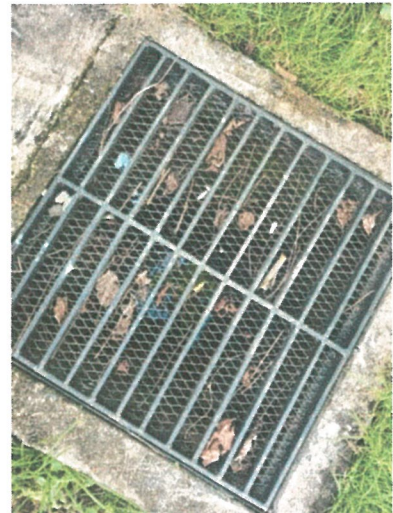
รูปภาพที่ 2.6 ตะแกรงดักขยะ และรางระบายน้ำ
