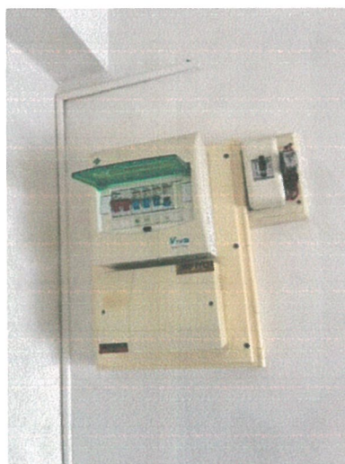
รูปภาพที่ 2.24 เครื่องตัดไฟอัตโนมัติ
