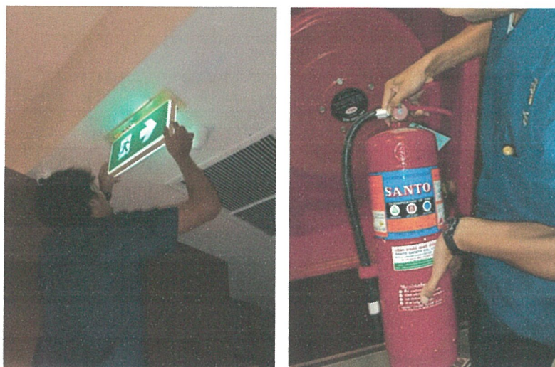
รูปภาพที่ 2.20 การตรวจสอบอุปกรณ์ป้องกันและแจ้งเตือนอัคคีภัย
