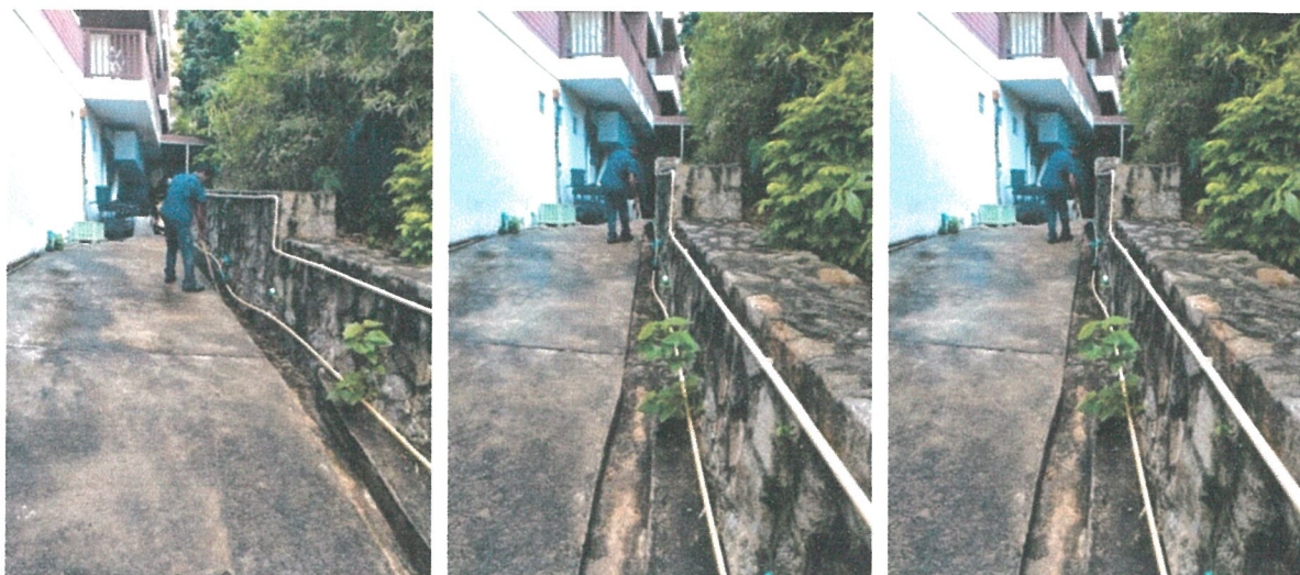
รูปภาพที่ 2.13 การขุดลอกตะกอน
