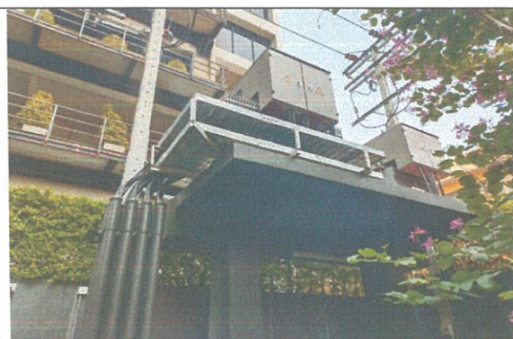
รูปที่ 3-39 หม้อแปลงไฟฟ้าที่มีการติดตั้งอันตรายไฟฟ้าแรงสูง
