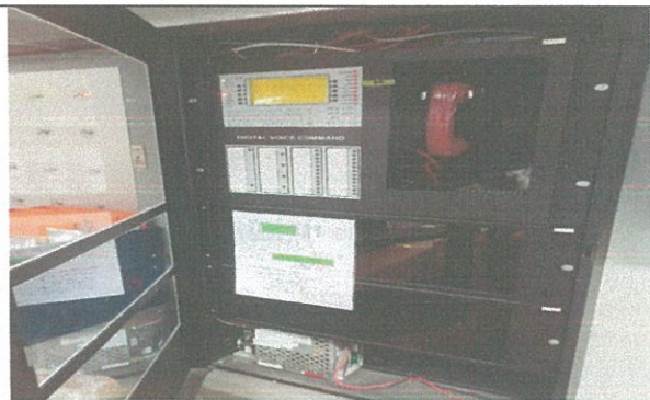
รูปที่ 3-53 แผงควบคุม (Fire Alarm Control Panel : FCP)
