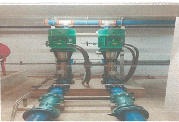
รูปที่ 3-18 ระบบสูบน้ำในอาคาร
