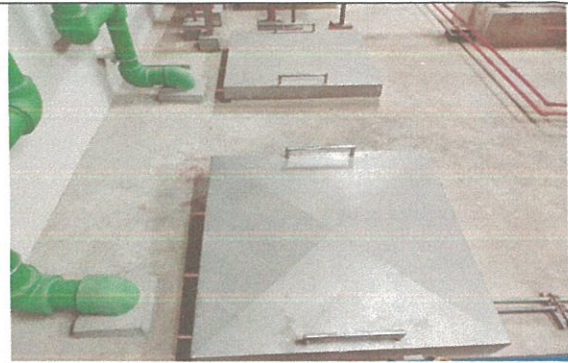
รูปที่ 3-15 ถังสำรองน้ำใต้ดิน
