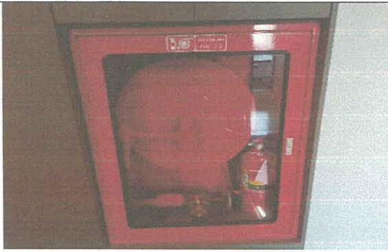
รูปที่ 3-51 ตู้เก็บสายดับเพลิง (Fire Hose Cabinet)
