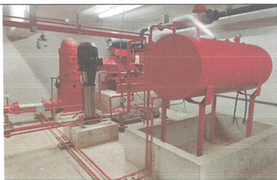
รูปที่ 3-40 เครื่องสูบน้ำดับเพลิง
