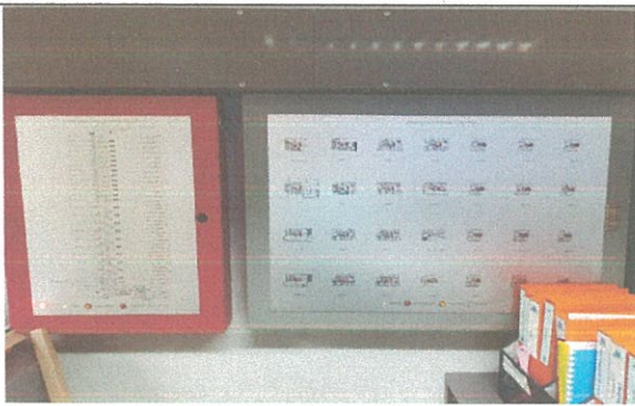
รูปที่ 3-53 แผงควบคุม (Fire Alarm Control Panel : FCP)
