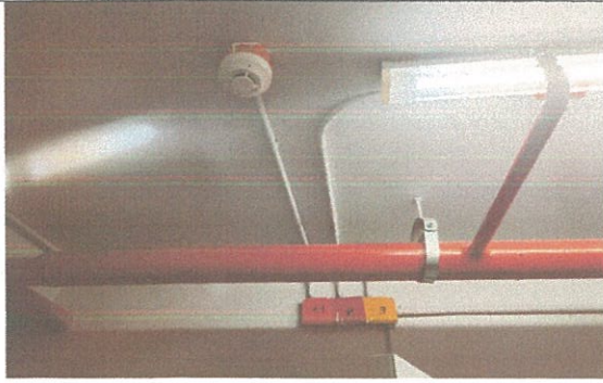
รูปที่ 3-49 เครื่องตรวจจับความร้อน (Heat Detector)
