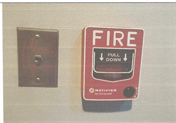
รูปที่ 3-42 เครื่องแจ้งเหตุโดยใช่มือดึง (Manual Station)
