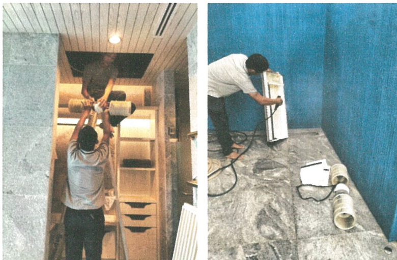
รูปภาพที่ 2.32 การทำความสะอาดเครื่องปรับอากาศ
