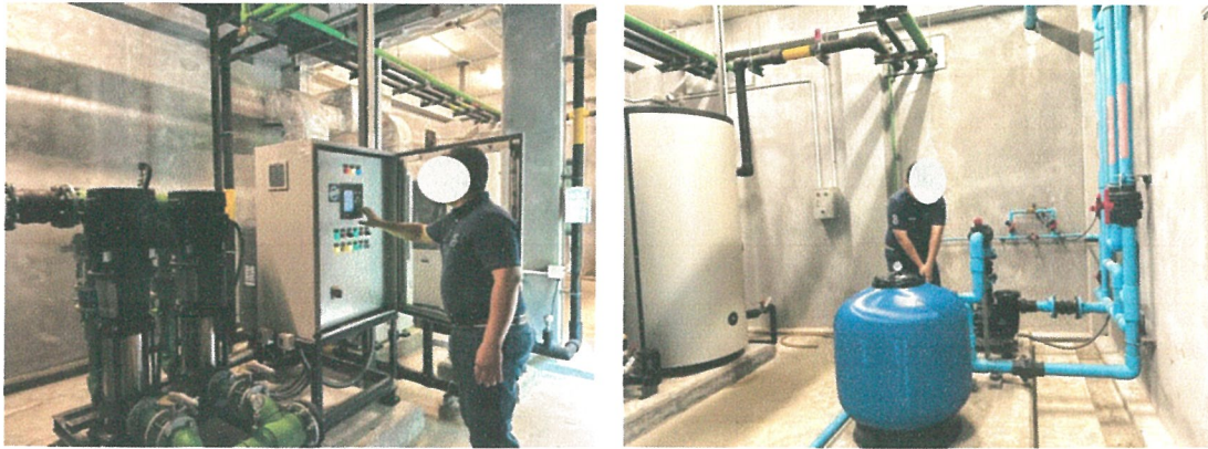
รูปภาพที่ 2.17 การตรวจเช็คเส้นท่อของระบบการจ่ายน้ำ
