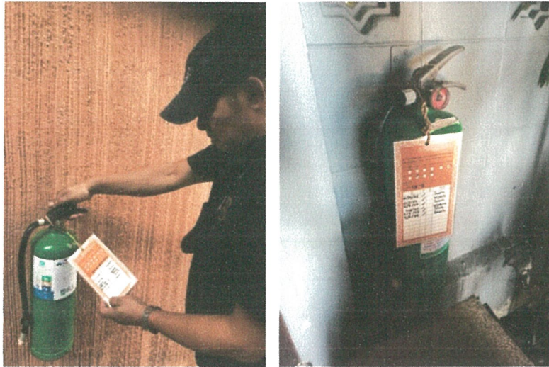
รูปภาพที่ 2.24 การตรวจสอบอุปกรณ์ป้องกันและแจ้งเตือนอัคคีภัย
