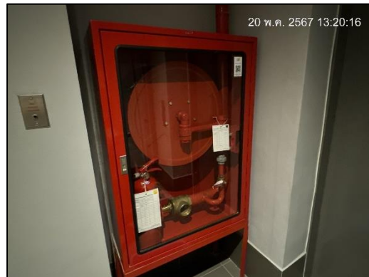
ภาพที่ 47 ตู้สายดับเพลิงและถังดับเพลิง
