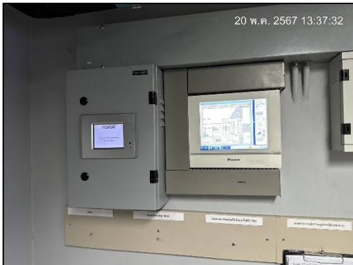
ภาพที่ 31 ระบบควบคุมไฟฟ้า Two Wire Remote
