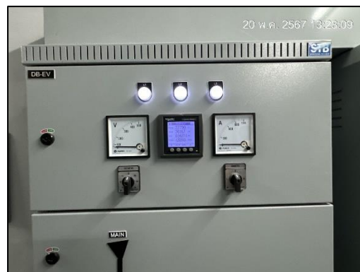
ภาพที่ 27 ชุด Power Monitoring ที่ตู้ MDB
