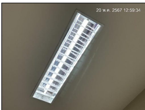
ภาพที่ 29 แผ่นช่วยสะท้อนแสงของหลอดไฟ
