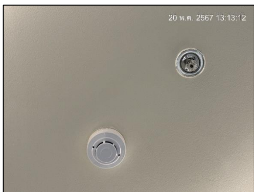
ภาพที่ 50 เครื่องตรวจจับควัน/ความร้อน
