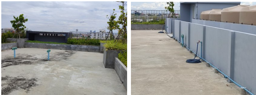
ภาพที่ 10-31 คาดฟ้าอาคาร มีรั้วกันป้องกันการพลัดตกจากอาคาร
