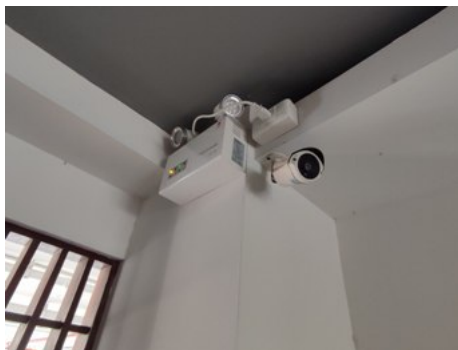
ภาพที่ 10-25 แผงควบคุมแจ้งเหตุเพลิงไหม้อัตโนมัติ ระบบโทรทัศน์วงจรปิด และกล้องวงจรปิด
